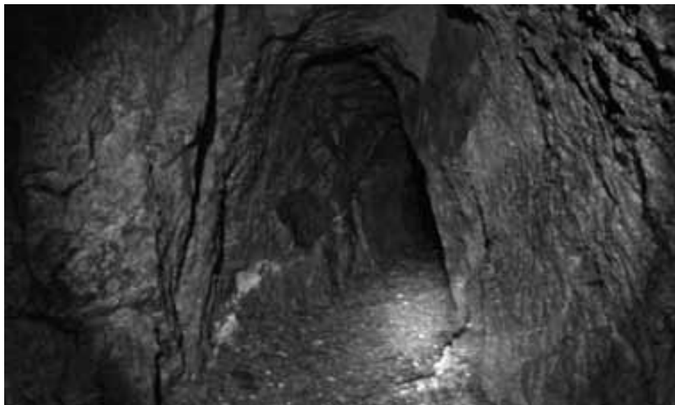
Im „Güte des Herrn Stolln“ in Obermildenau Foto: H. Melzer
