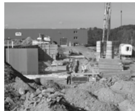
aktuelles Baugeschehen des Hallenneubaus
