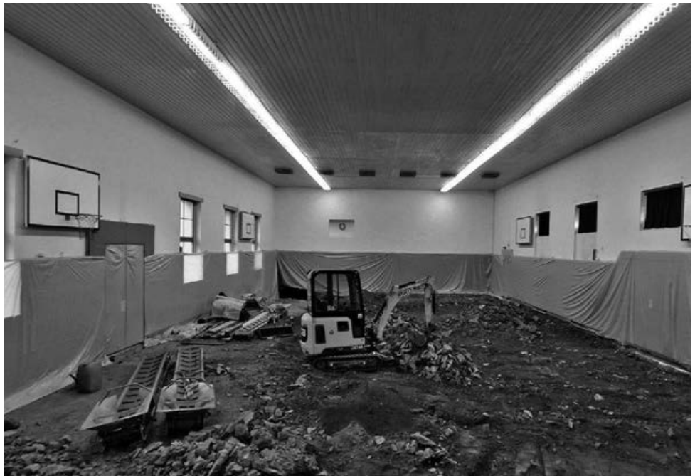
Mildenauer Turnhalle während der Erneuerung des Hallenbodens mit Vorbereitung des Unterbaus.
