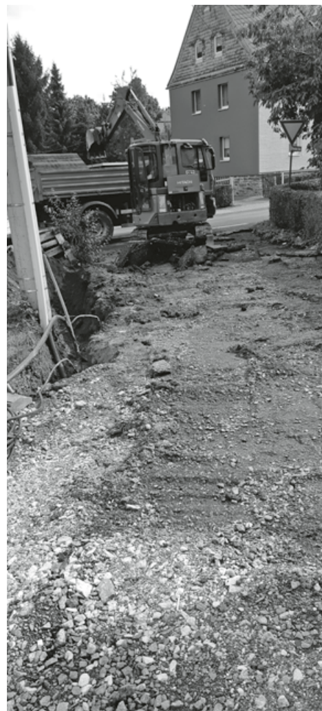
Deckensanierung der Zufahrtsstraße zum KDZM
