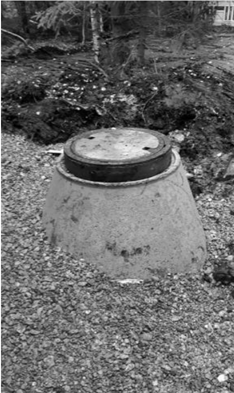
neuer Quellschacht im Quellgebiet Obermildenau
