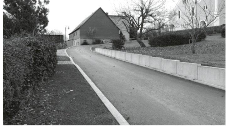
Ausbau des Kirchsteiges in Neundorf
