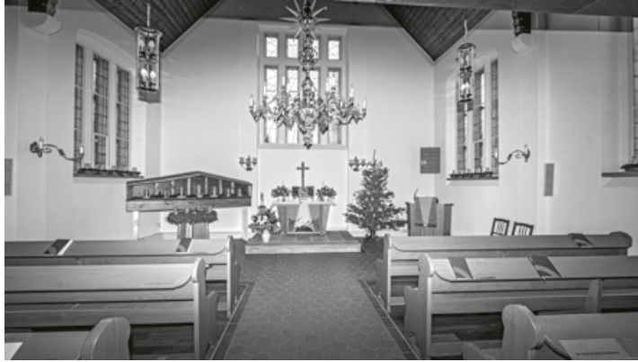
Innensanierung der Friedhofskapelle Hilmersdorf
