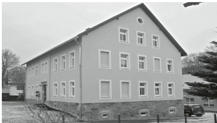
Fassadensanierung in Sehmatal-Sehma
