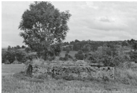
Ehemaliges Fundament für die Seilwinde
