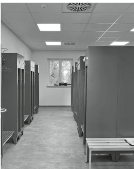
neuer Umkleideraum der FFW-Kameraden
